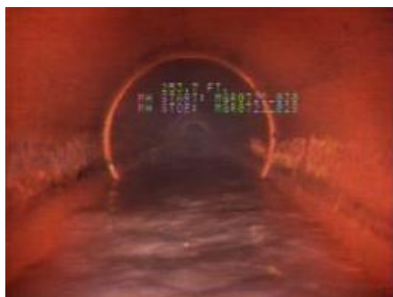
Przekrój rury kanalizacyjnej po mechanicznym czyszczeniu.
